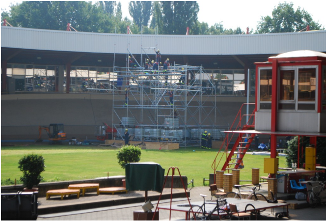
Gerüstbau für die Deutsche Feuerwehrmeisterschaft in Cottbus
