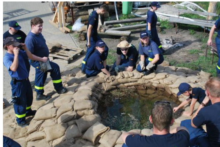
Bau von einer Quellkade zur DV
