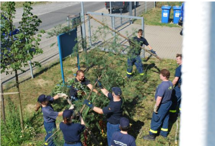
Bau von Faschienen zur Deichverteidigung
