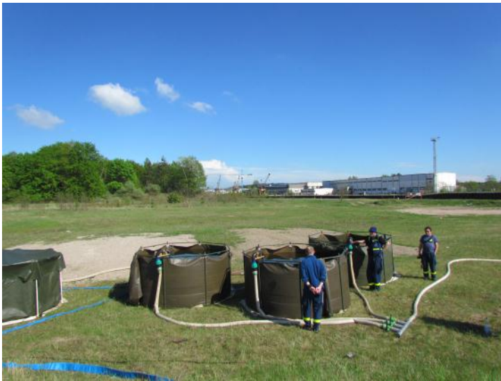
Aufbau von Trinkwasserspeichern
